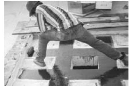
M-BRACE® puede utilizarse para sustituir aceros de refuerzo que se corten una vez se hagan penetraciones a través de una losa, viga o un muro de concreto.
